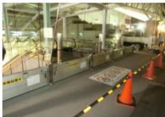
止水板の設置・訓練 (安心・安全)
